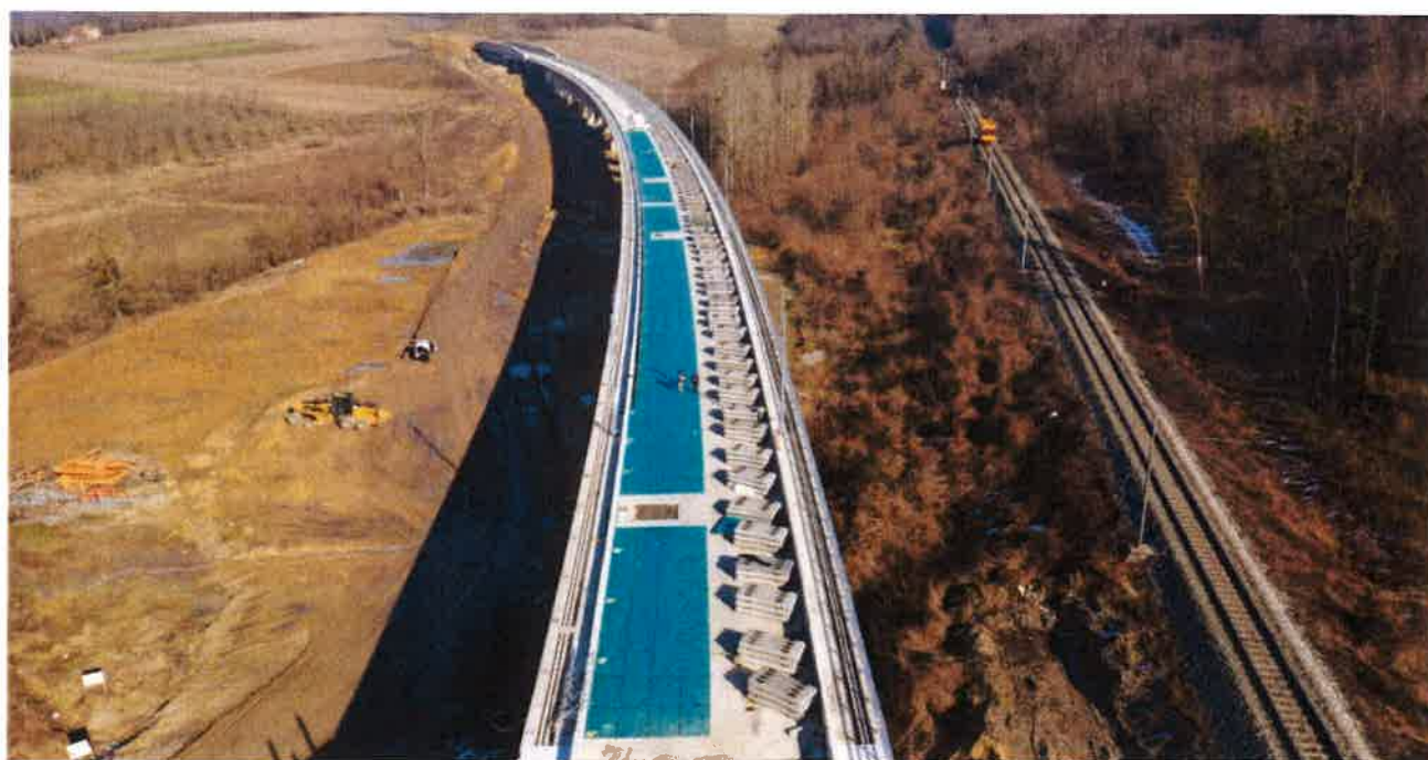
Slika 4. Izgradnja nove pruge i vijadukta Carevdar iz EU fondova
