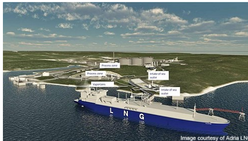
Slika: 2.5.1. onshore LNG terminal
