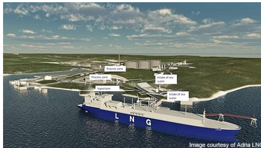
Slika: 2.5.1. onshore LNG terminal
