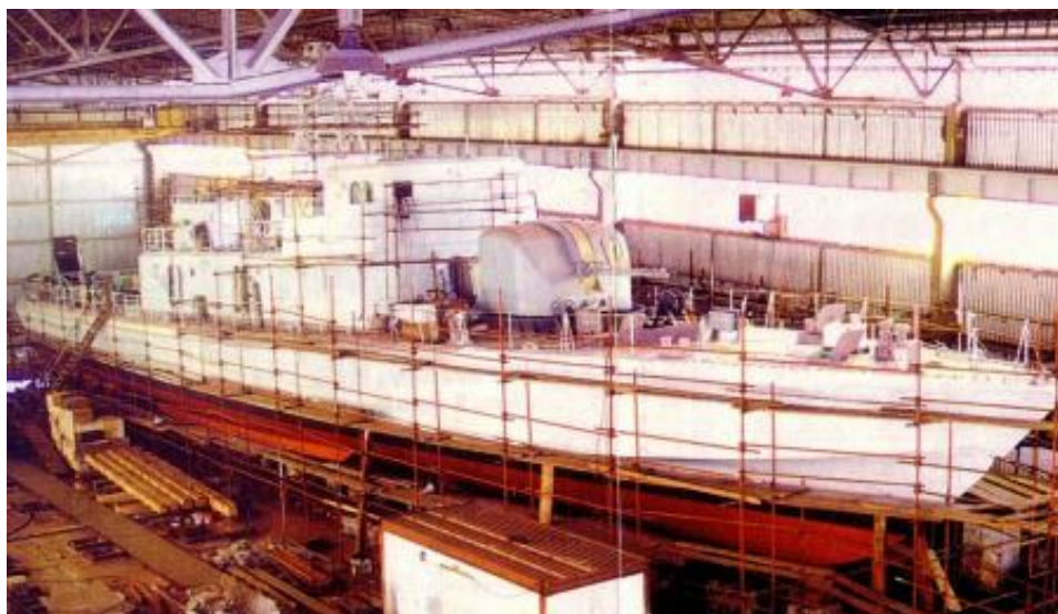
Slika 2.4 RTOP-12 „Kralj Dmitar Zvonimir“ u izgradnji
