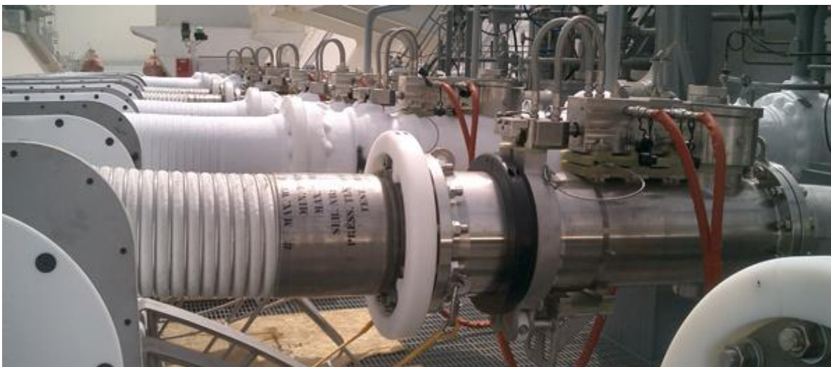
Slika 7: spojnice za hitno otpuštanje
