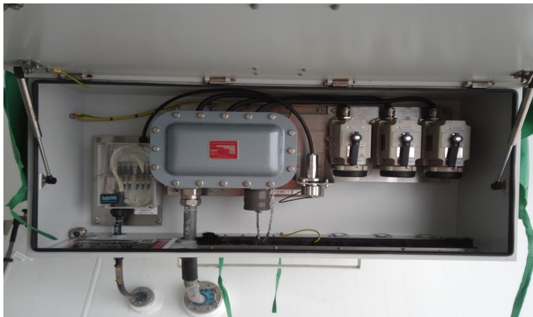
Slika 21: priključna kutija ESD-a FSRU Hoegh Giant
