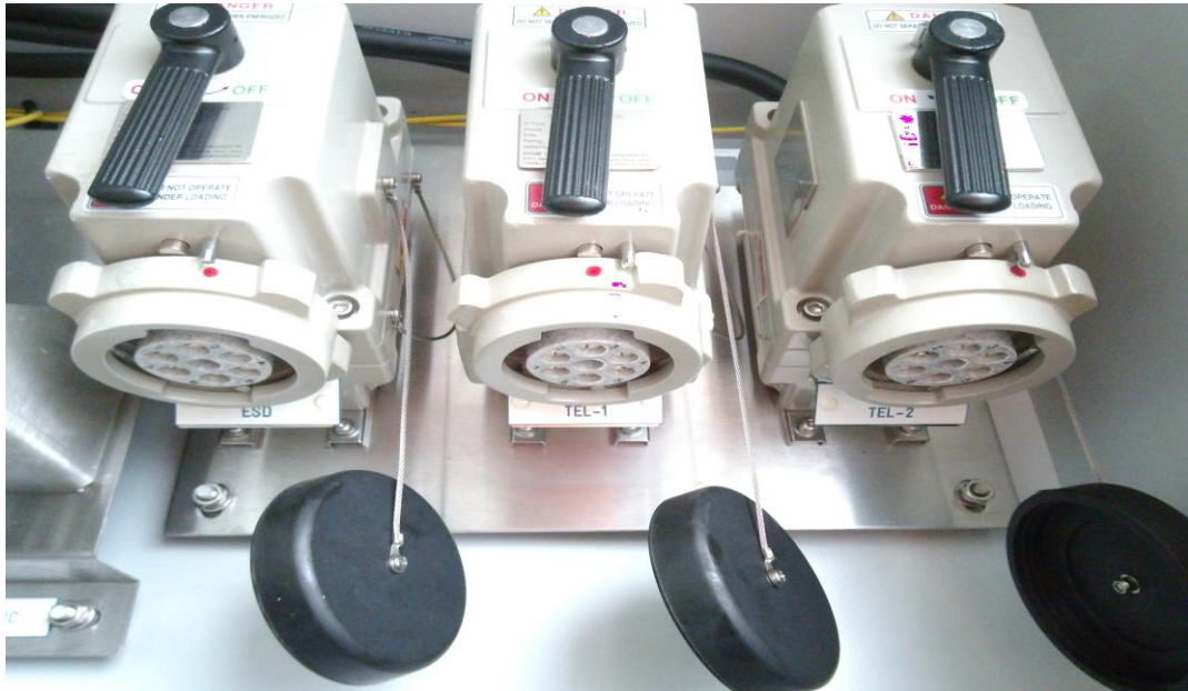
Slika 20: konektori ESD-a Hoegh Giant
