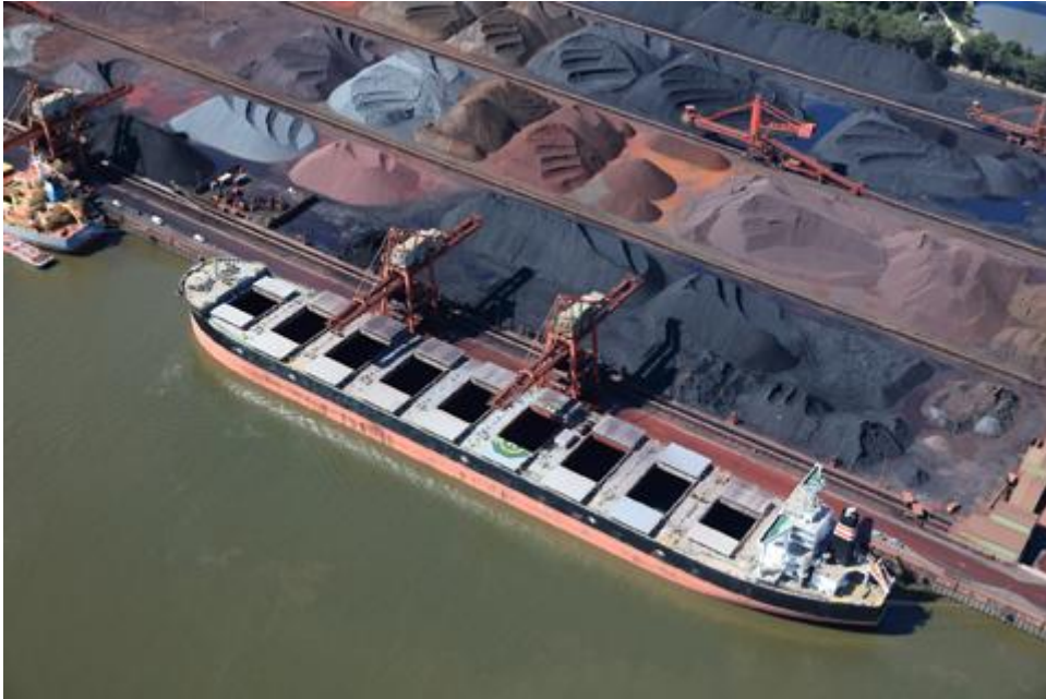
Slika 8. Terminal za rasuti teret
