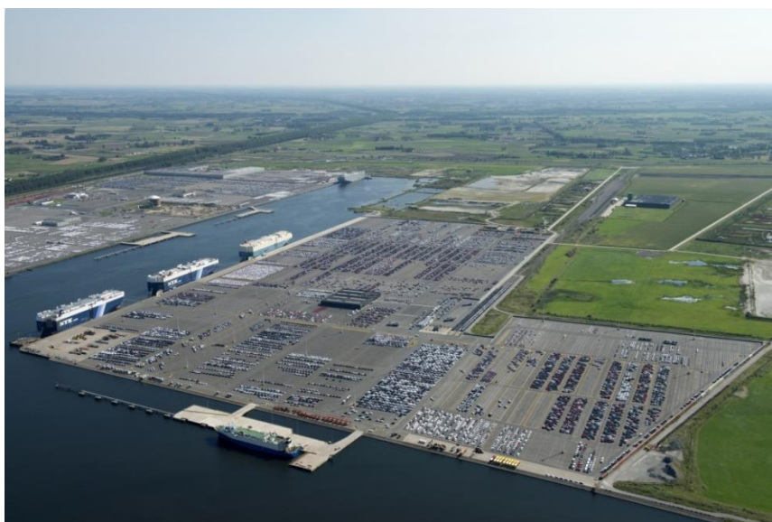
Slika 12 Zeebrugge RO-RO terminal
