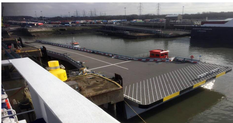
Slika 15 "Linkspan" obalna rampa
