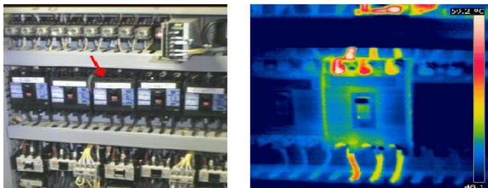
Slika 51: Termovizija elektrosklopnika
