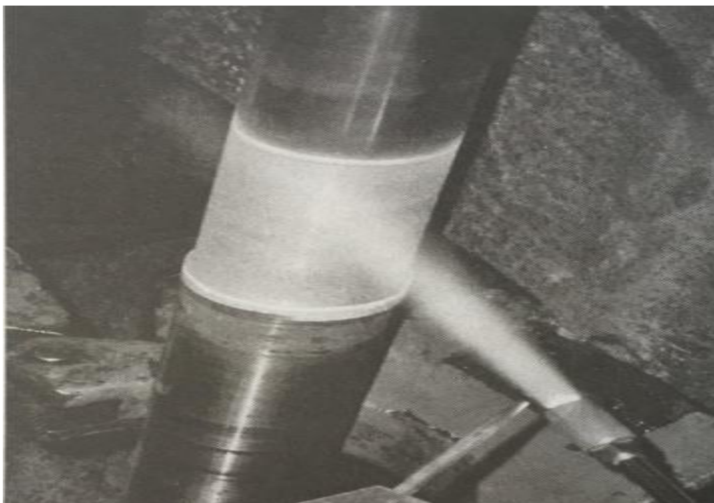
Slika 2. Prikaz pripreme površine predgrijavanjem prije toplinskog naštrcavanja
