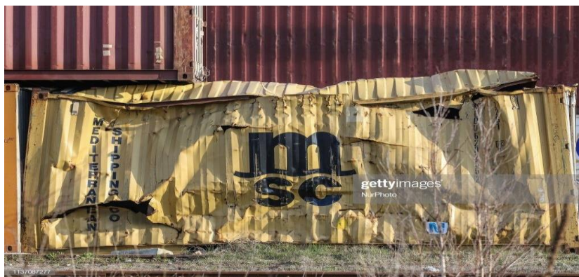
Slika 13. Primjer oštećenja kontejnera prvog stupnja
