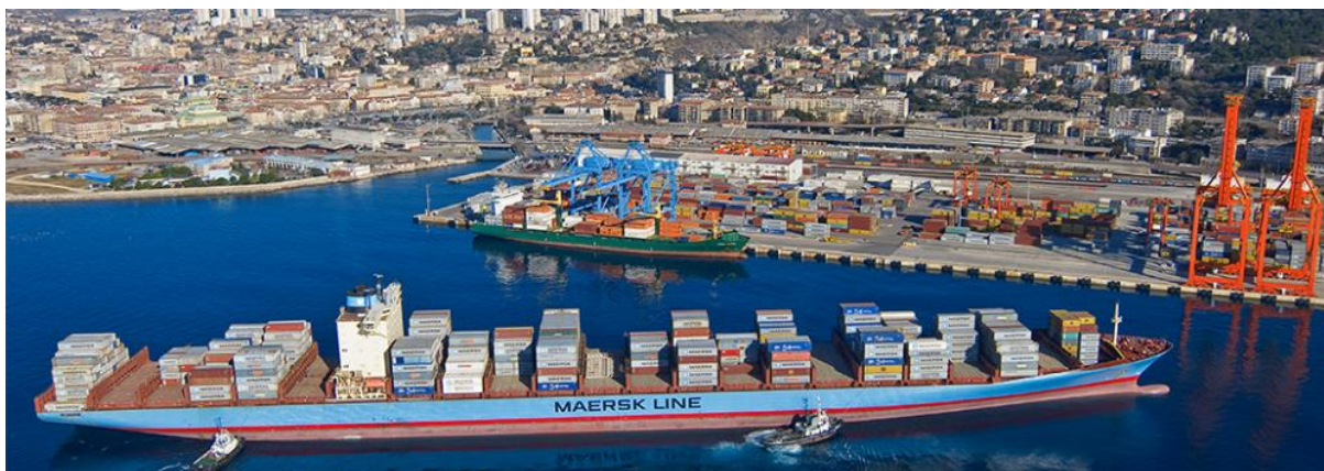
Slika 5. Kontejnerski terminal Jadranska vrata
