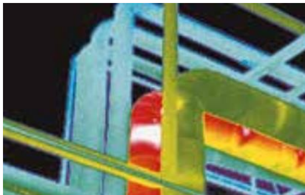
Slika 17. Oštećenje izolacije
