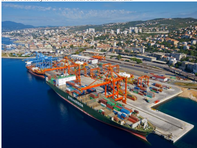
Slika 3. Kontejnerski terminal Jadranska vrata
