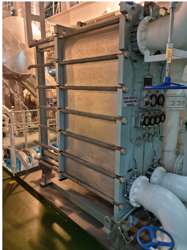
Slika 6. Rashladnik zraka odvojen od glavnog motora [7]
