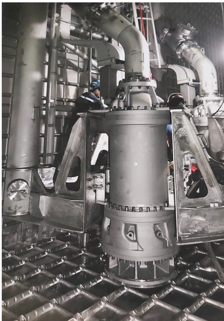
Slika 13 Remontno održavanje pumpi tereta na LNG brodu
