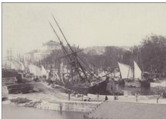
Slika 1 Nagibanje jedrenjaka i barcere u svrhu održavanja ( na karenu)
