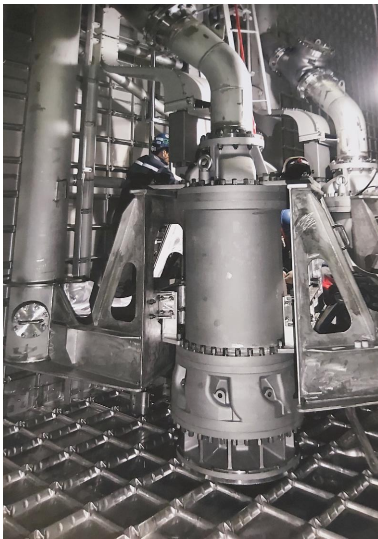
Slika 13 Remontno održavanje pumpi tereta na LNG brodu
