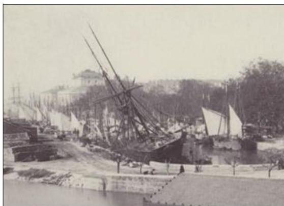
Slika 1 Nagibanje jedrenjaka i barcere u svrhu održavanja ( na karenu)
