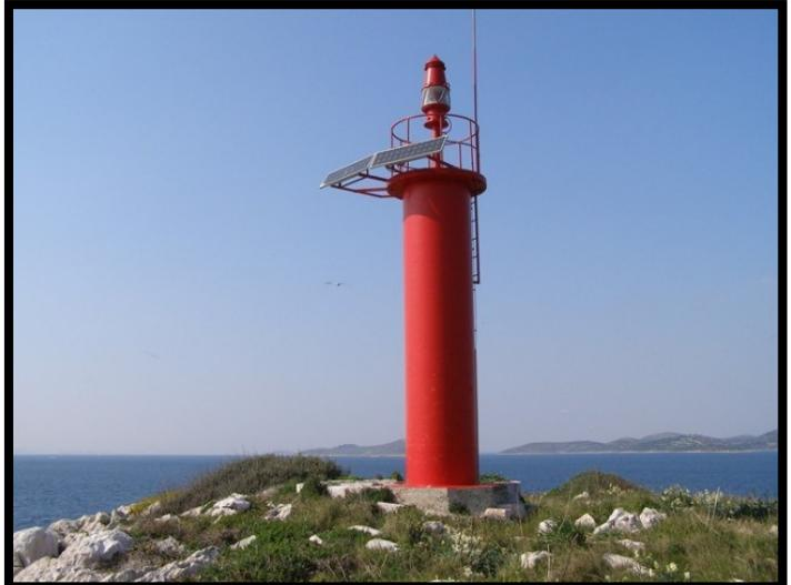
Slika 25 Obalno svjetlo sa ugrađenim solarnim panelima za napajanje
