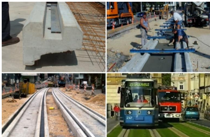
Slika 4. Faze izgradnje sistema „INFUNDO LR–HFT“ (Hohnecker, 2004) i izgled koloseka sa zelenim pokrivačem ( https://www.youtube.com/watch?v=VV5QiiV6k0 , 20.08.2021.)
