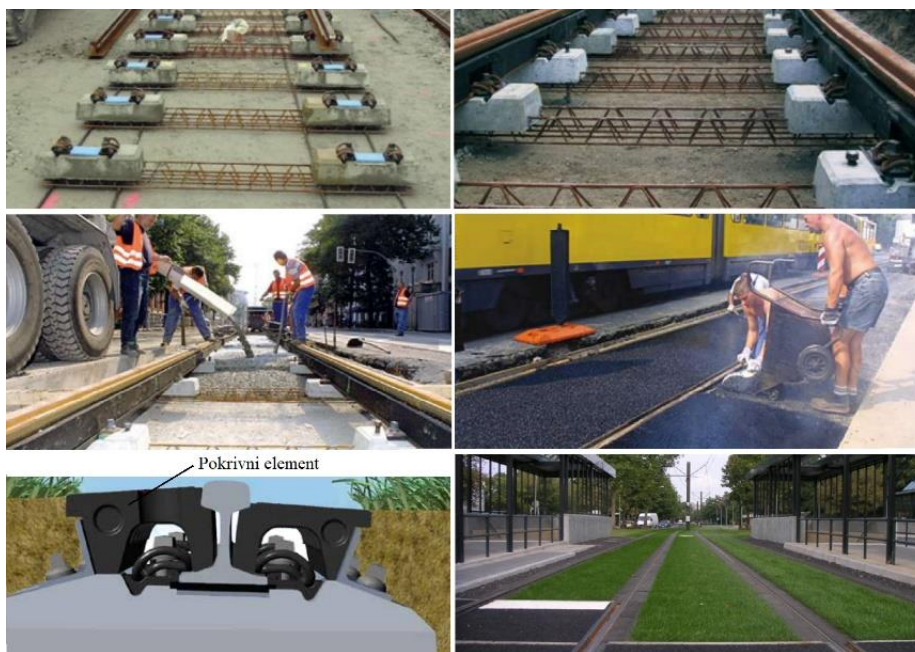
Slika 3. Faze izgradnje sistema „Rheda City“
