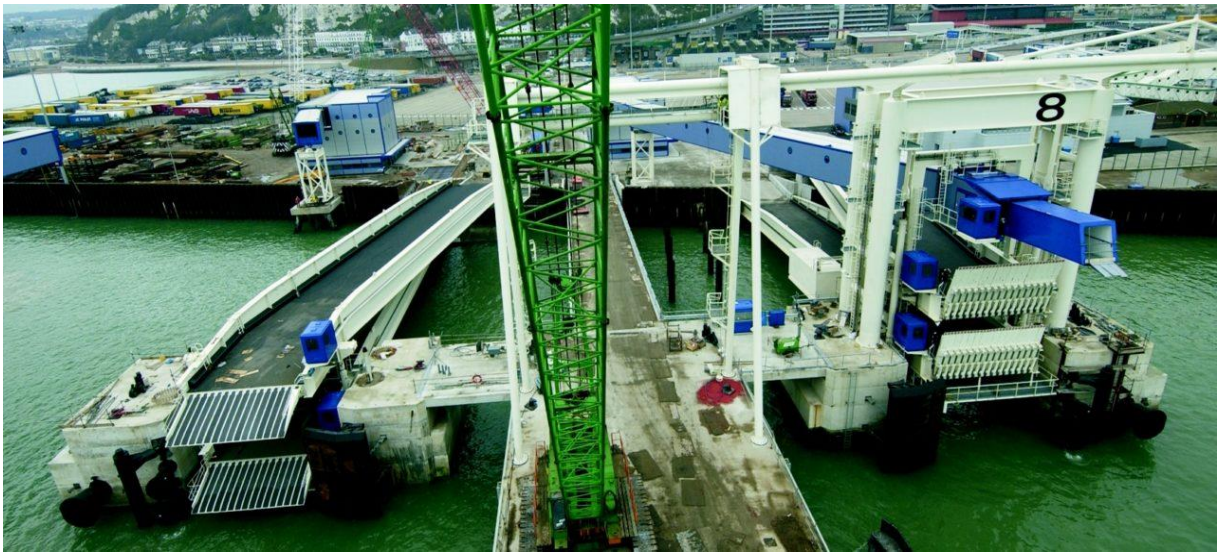
Slika 15. Mosna rampa za prihvat dva broda istovremeno
