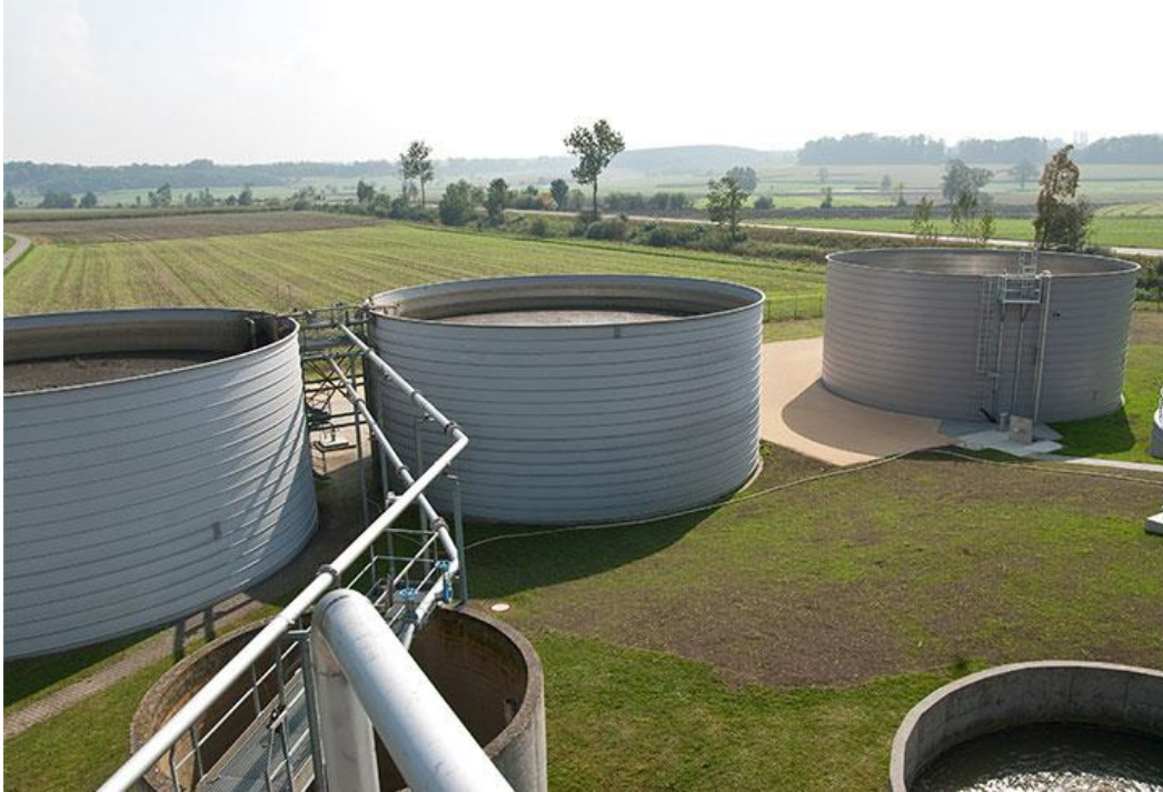
Slika 8. Spremnici za skladištenje tekućih tereta
