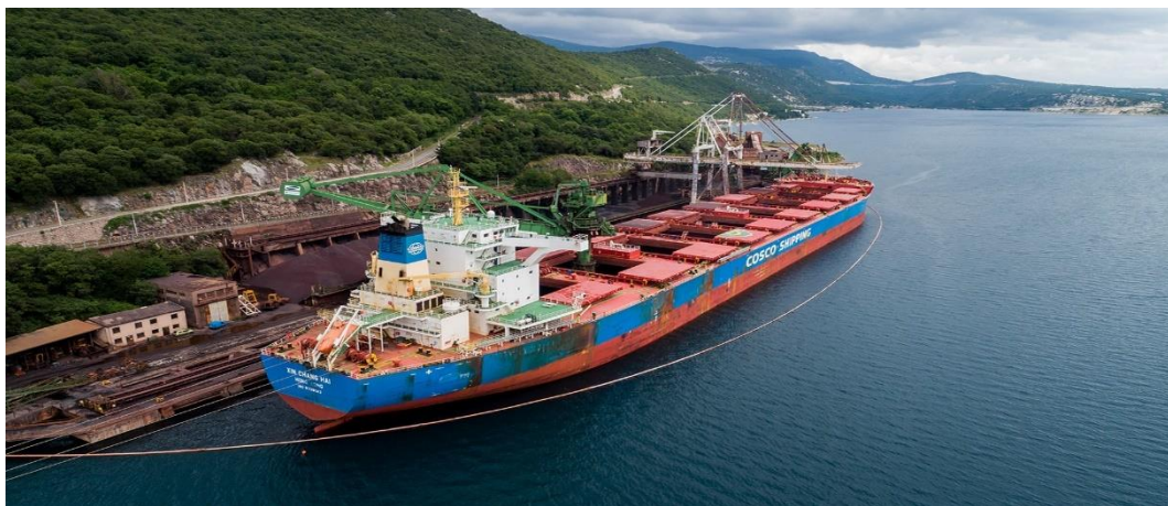
Slika 18: Terminal za rasuti teret-Bakar
