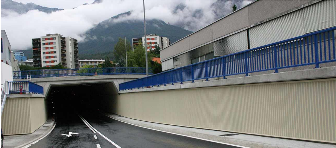
Slika 37. Zid podvožnjaka obložen apsorbirajućim panelom
