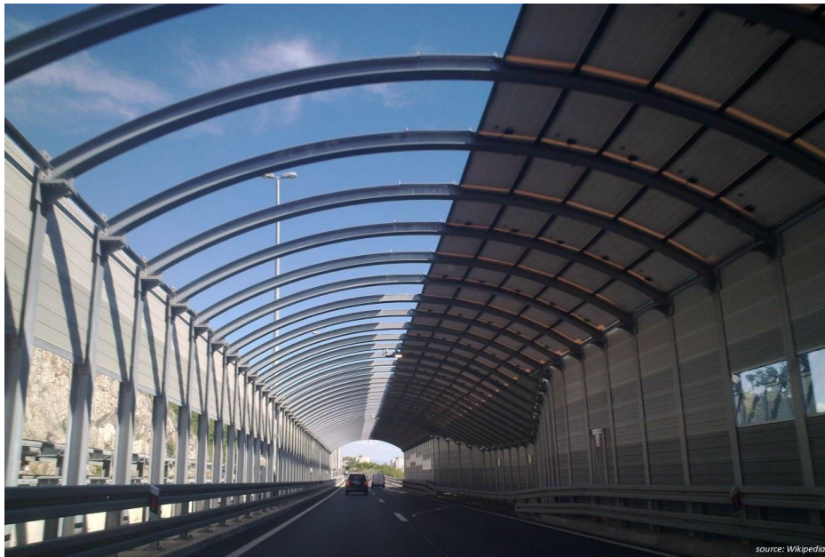
Slika 36. Prozirna barijera za zaštitu od buke
