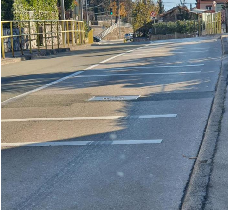
Slika 20. Vibracijska traka
