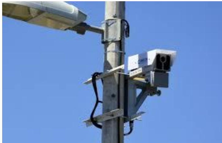
Slika 26. Sustav videodetekcije koja upotrebom kamere bilježi prometne prekršaje
