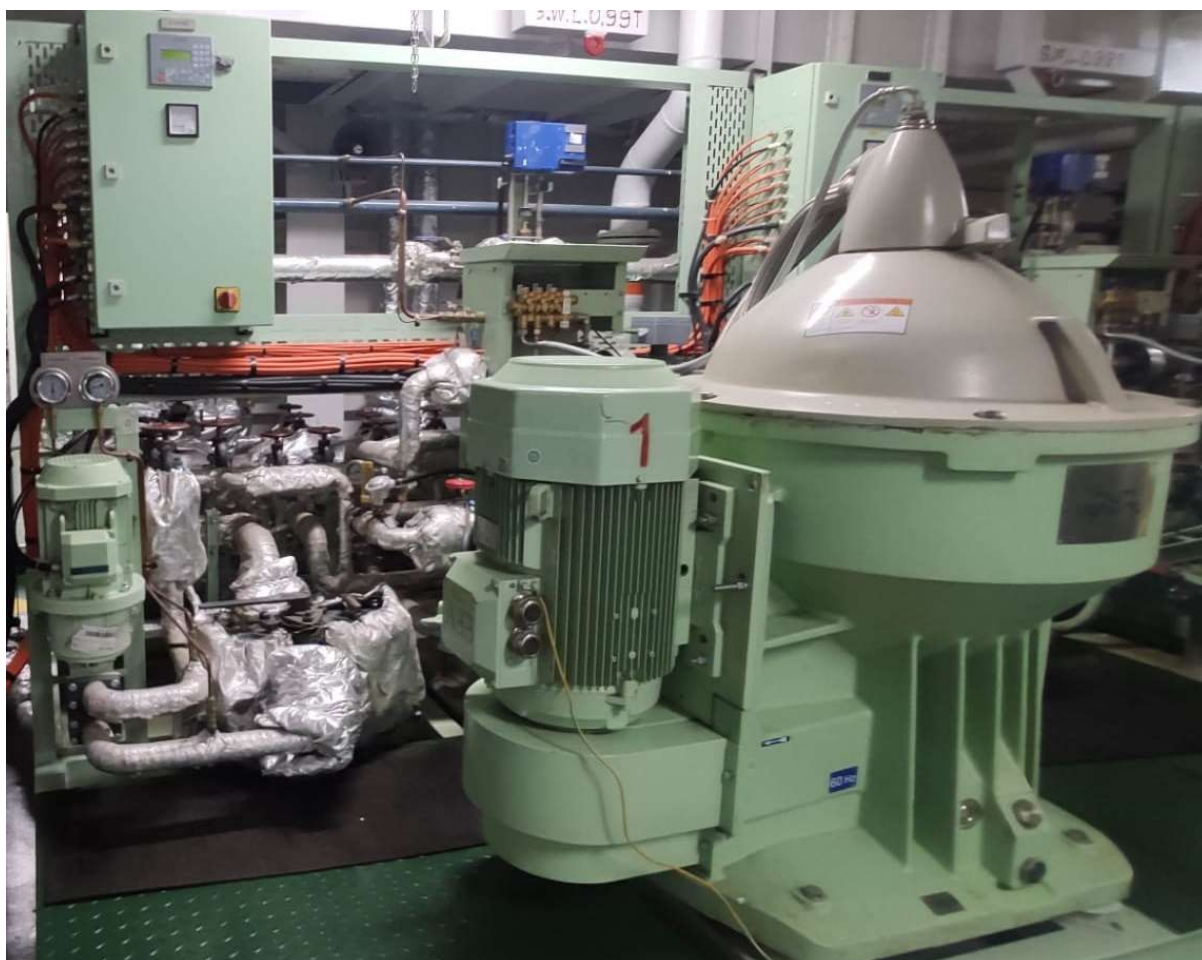
Slika 10. Prikaz separatora „Alfa Laval“ s pripadajućim uređajima
