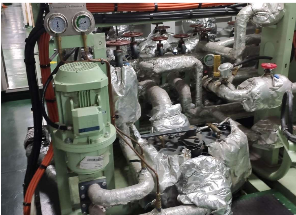
Slika 4. Prikaz napojne pumpe s usisnim filterom
