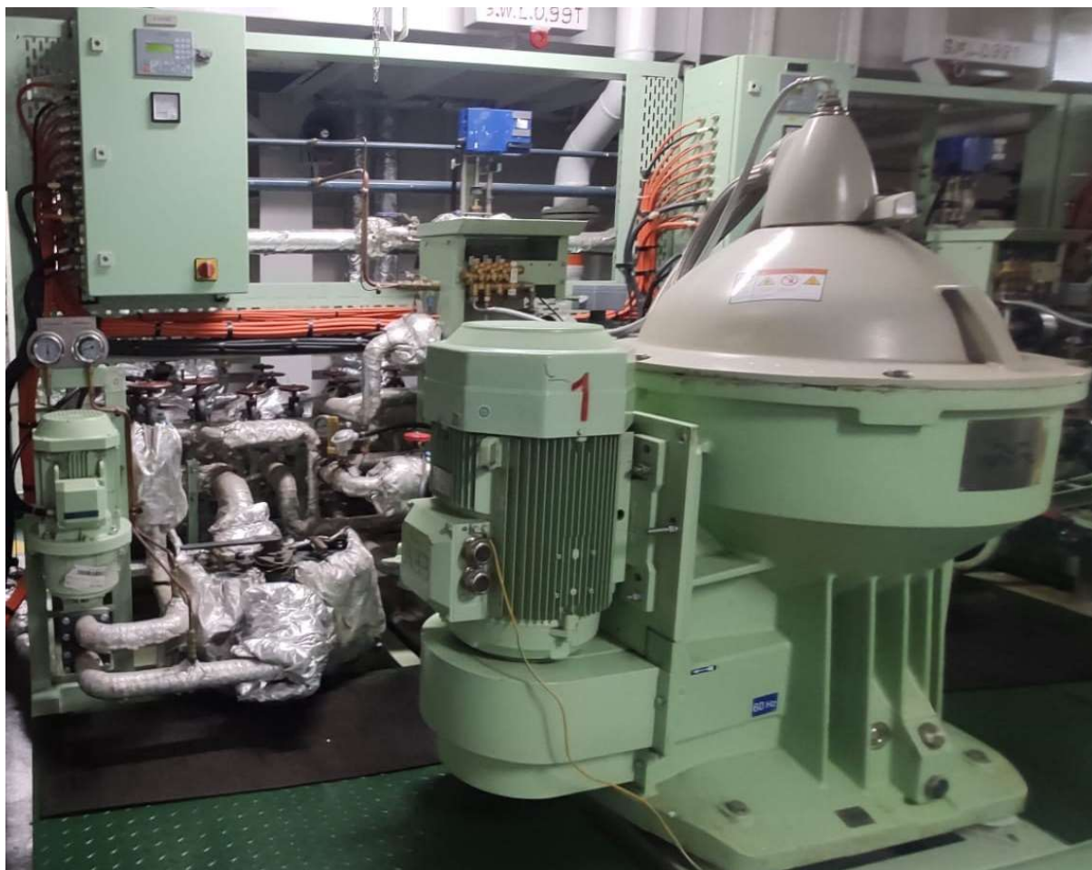
Slika 10. Prikaz separatora „Alfa Laval“ s pripadajućim uređajima
