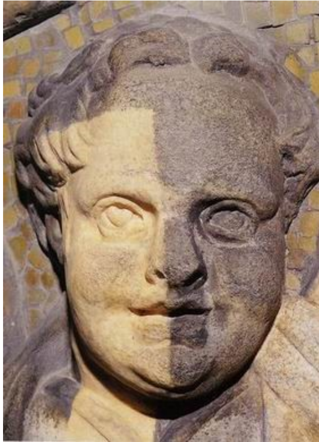
Slika 13. Primjer čišćenja kamena pomoću lasera
