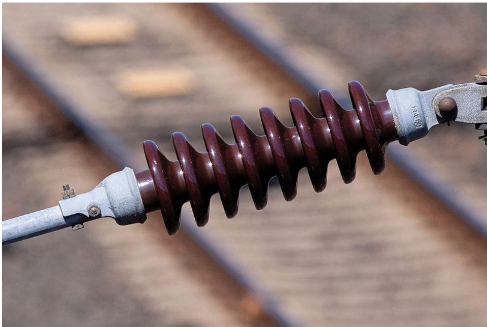
Slika 4-Primjer čahure izradene od keramike
