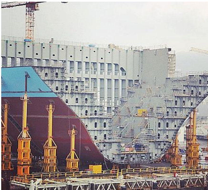
Slika 9. Presjek broda Triple E klase, u izgradnji
