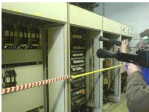
Slika 17. Ultrazvučno ispitivanje elektro ormara
