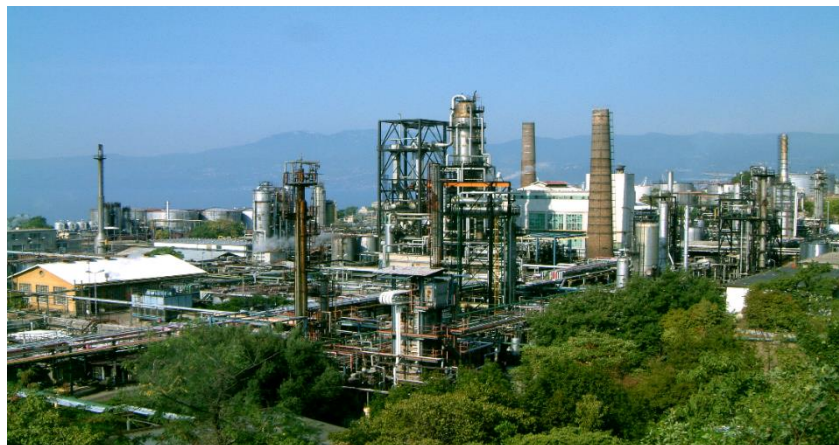
Slika 1. Rafinerija nafte Rijeka - Postrojenja Maziva – Mlaka [17]
