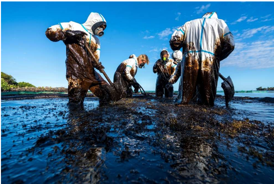
Slika 9 - Mehaničko čišćenje ulja na obali
