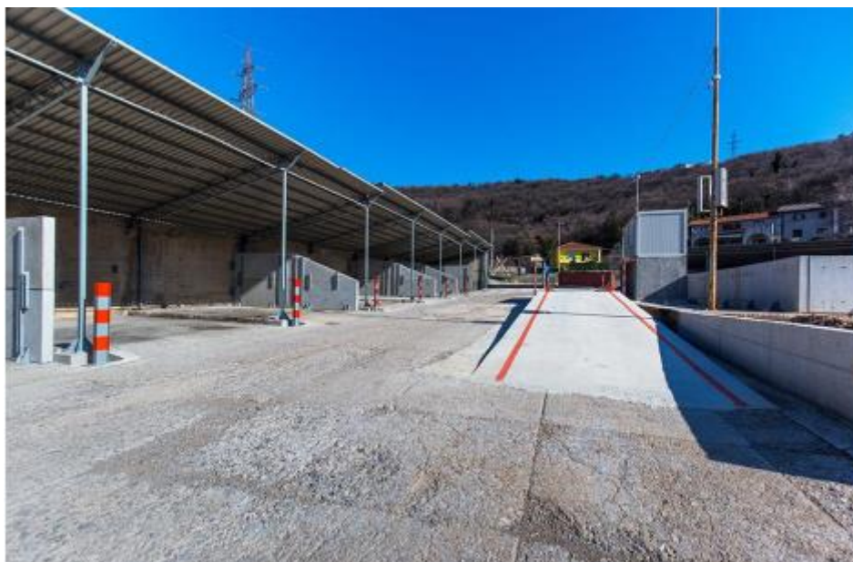
Slika 6. Reciklažno dvorište za građevni otpad
