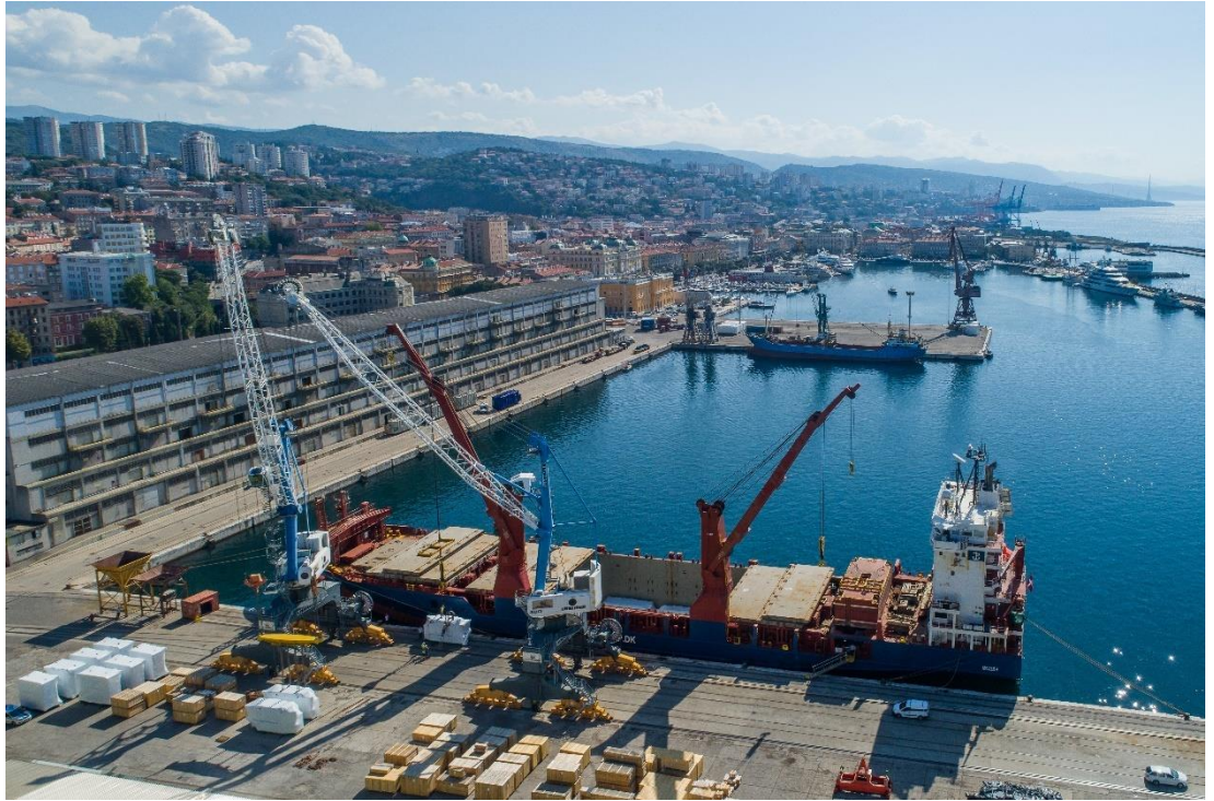
Slika 4. Terminal za generalni teret
