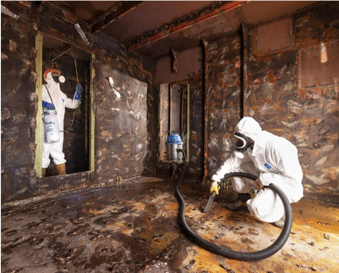
Slika 6. Skidanja azbesta sa broda Galeb
