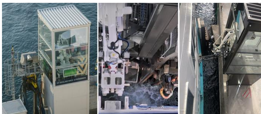
Slika 28: Automatsko sučelje sustava kopnenog priključka temeljeno na ABB IRB7600 robotskoj ruci na ro-ro putničkom brodu „Tycho Brahe“; Kopneni dio sučelja (lijevo); Povezivanje priključka robotskom rukom (sredina); Kopneni priključak spojen s brodskim dijelom sučelja (desno)
