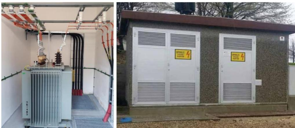
*Slika 6: Karakteristična KTS/TS transformatorska stanica snage transformatora 1000 kVA*
