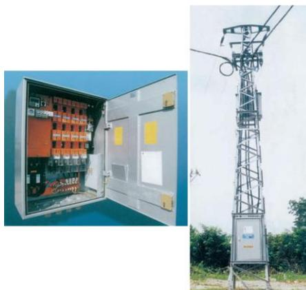
*Slika 7: Karakteristična stupna transformatorska stanica na čelično-rešetkastom stupu i niskonaponski razvodni ormarić
