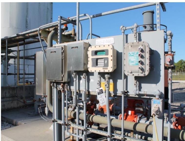
Slika 24. Računalo protoka FMC
