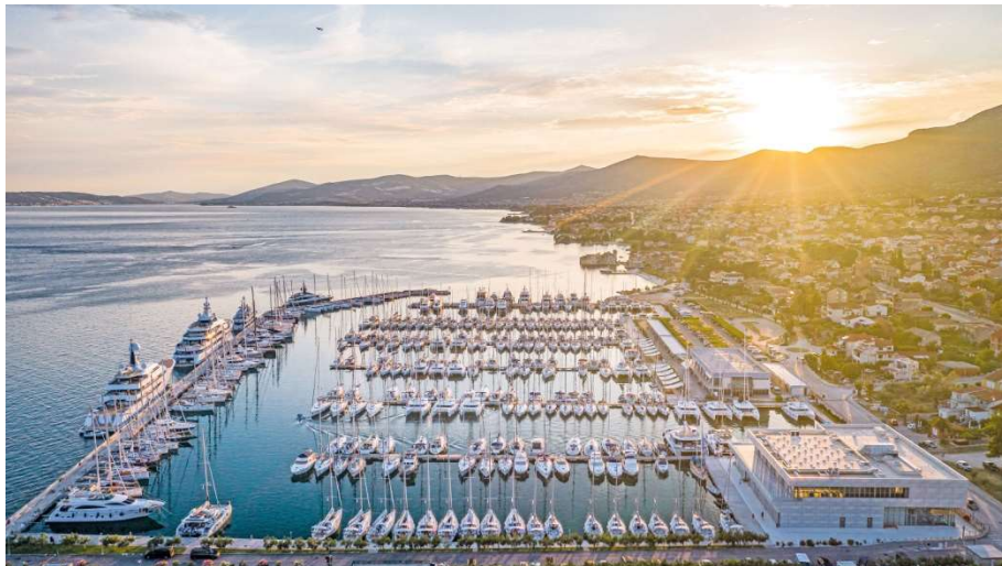
Slika 2. Marina Kaštela – primjer otvorenog tipa marine
