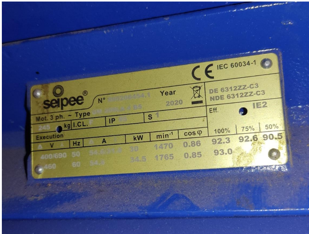
Slika 9. Natpisna pločica jednog od pet trofaznih asinkronih motora.
