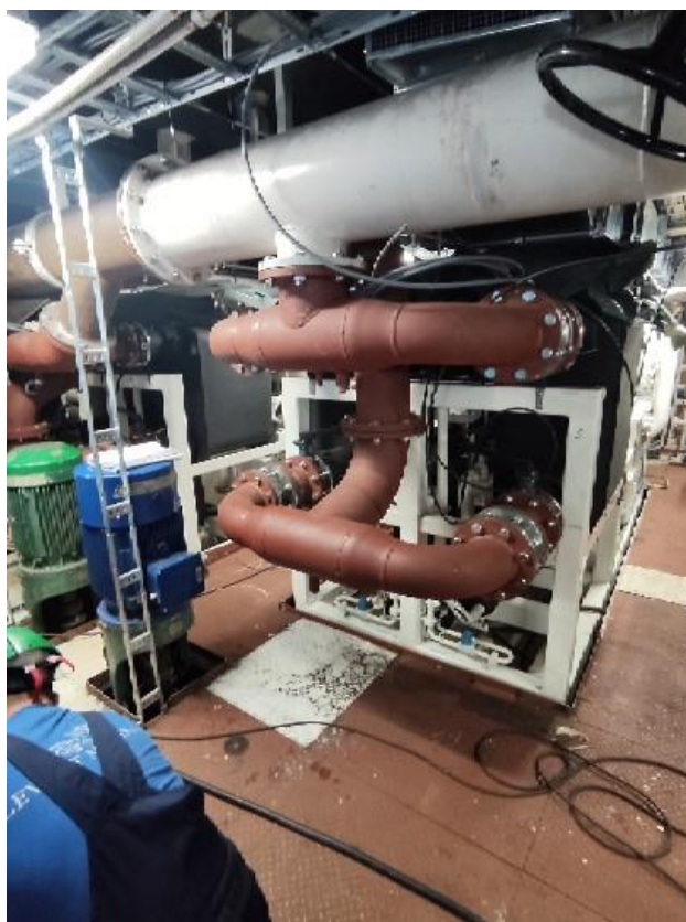
Slika 7. Jedna od 3 rashladne jedinice na brodu
