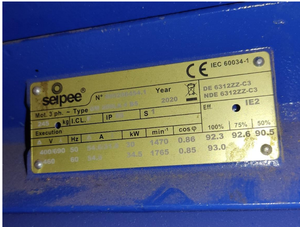
Slika 9. Natpisna pločica jednog od pet trofaznih asinkronih motora.
