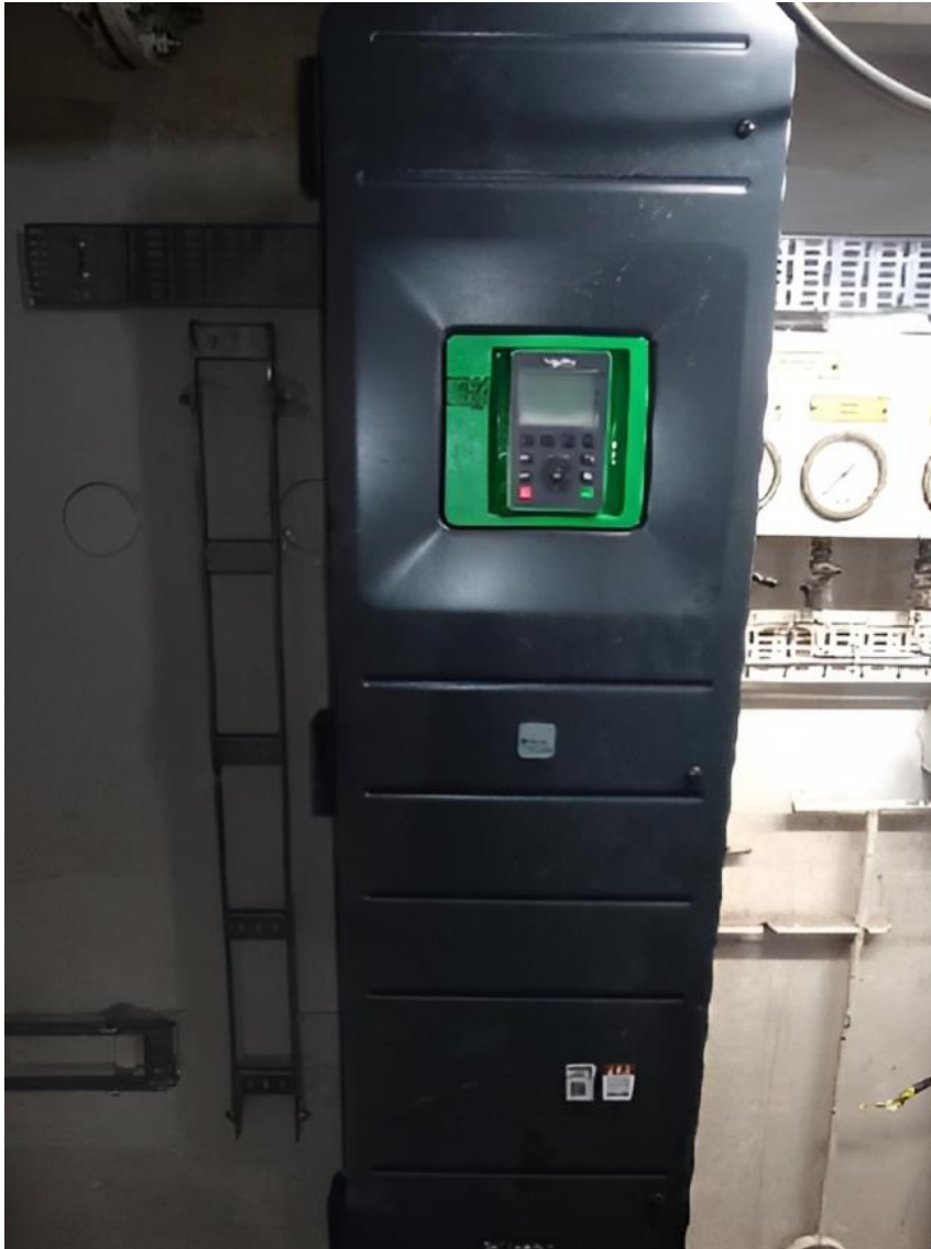
Slika 31. Slika jednog od 2 frekvencijska pretvarača.
