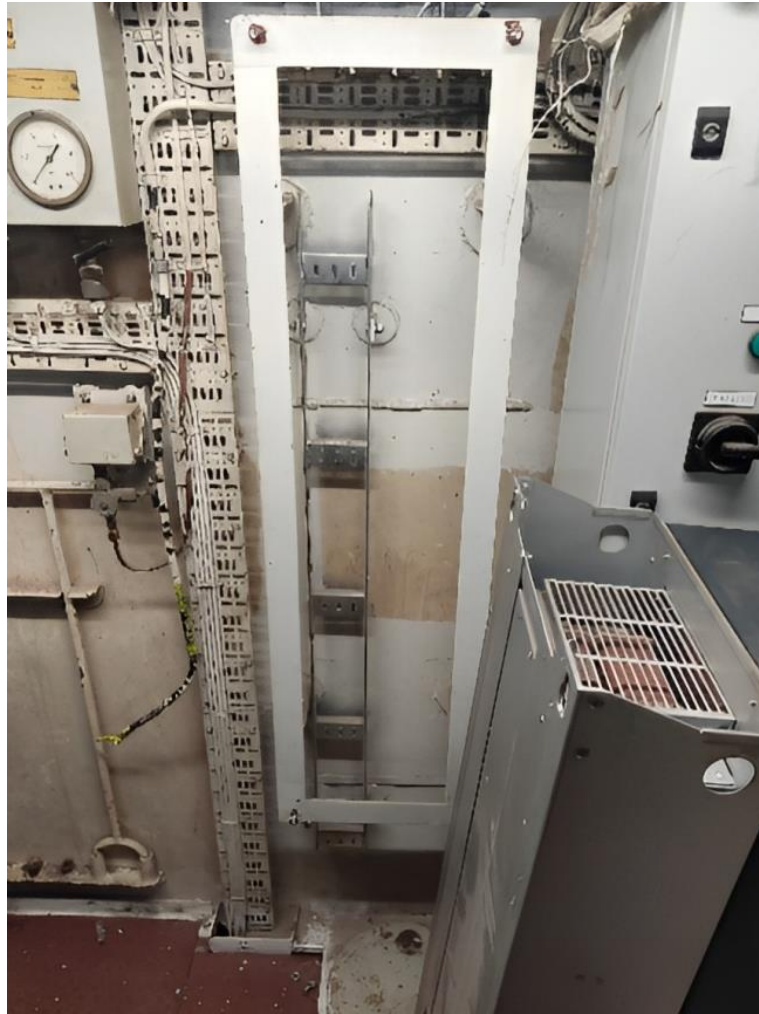
Slika 33. Primjer temelja za jednog od ormara postavljenih na brodu.
