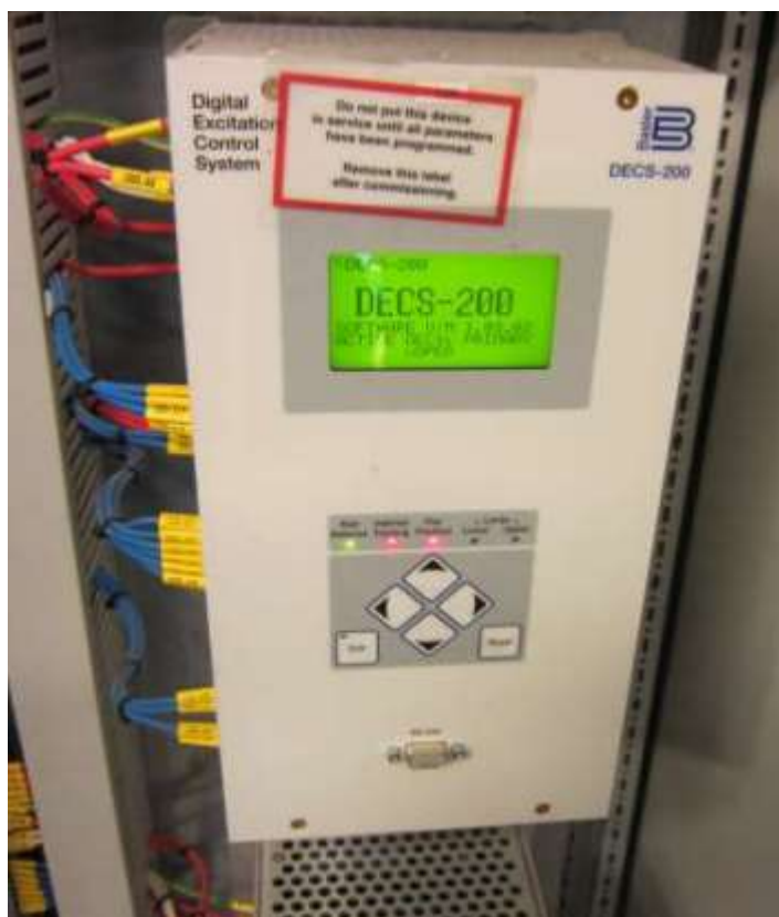
Slika 9 Automatski regulator napon
