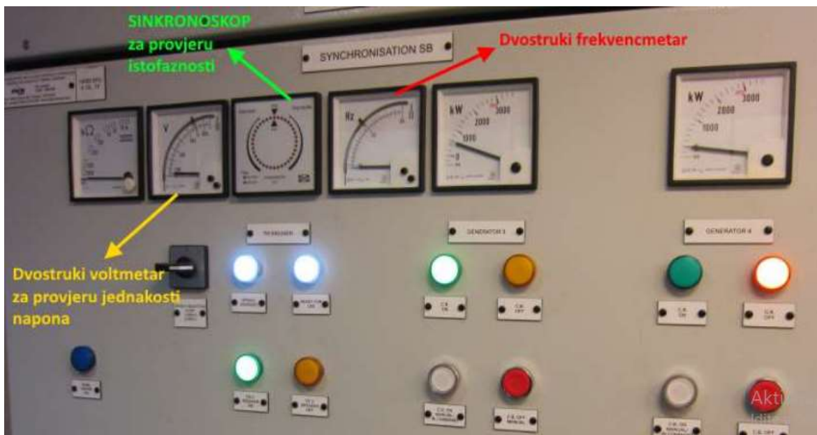
Slika 2 Polje za sinkronizaciju generatora i instrumenti koji se koriste za provjeru uvjeta sinkronizacije
