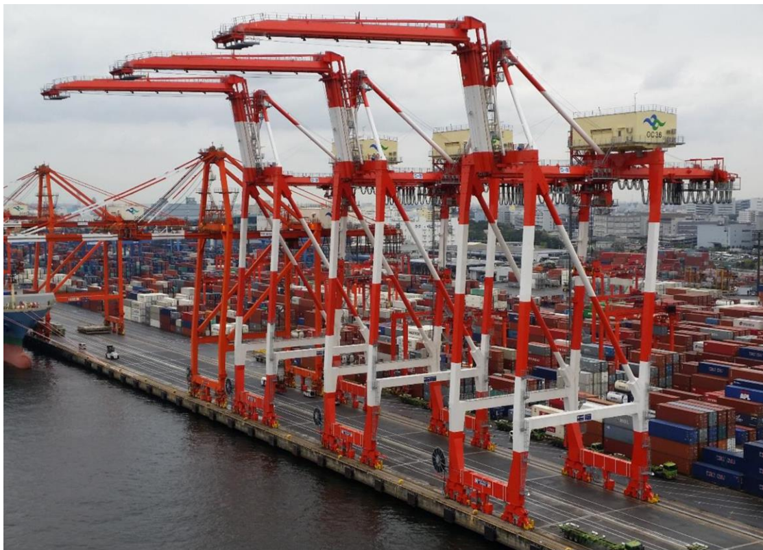
Slika 1. Kontejnerska obalna dizalica
