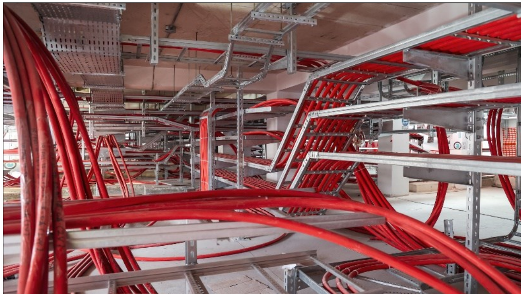
Slika 16. Visokonaponska kabelska mreža
