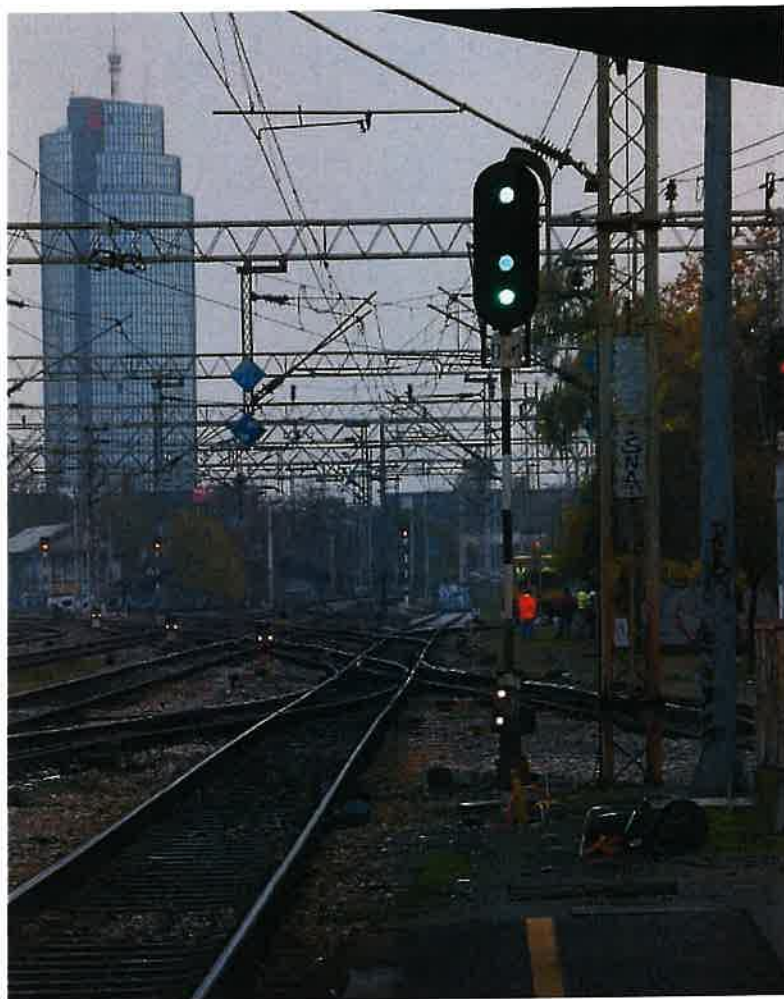
Slika 14. Izlazni signal na kolodvoru Zagreb GK, sa sve tri skupine signala.
