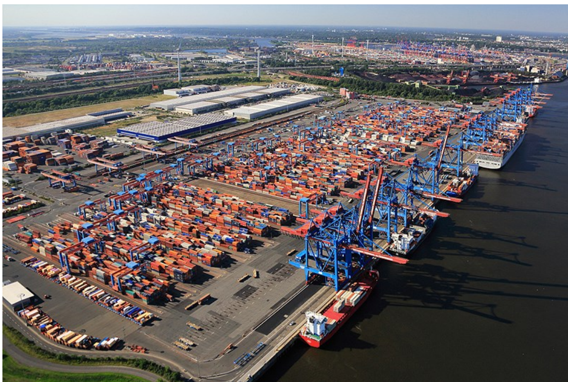
Slika 8. Kontejnerski terminal Altenwerder
