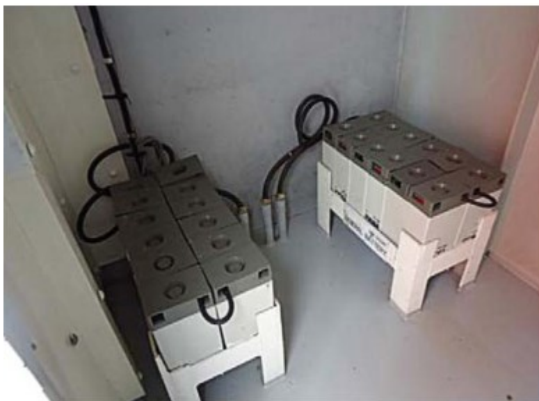
Slika 13. Primjer baterijske stanice na brodu
